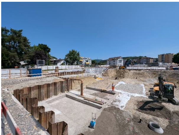
Abbildung 1: Sohlensaubau, Einbau Sickerteppich + Magerbetonsohle
