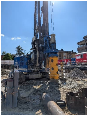
Abbildung 3: Erstellung Filterbrunnen
