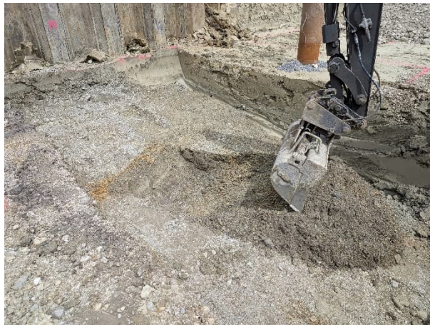
Abbildung 4: Übergang Schwemmsedimente - Bachablagerungen
