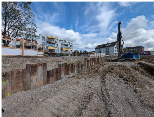
Abbildung 2: Spundwandarbeiten
