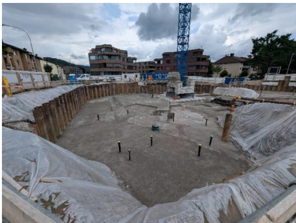
Abbildung 5: Übergabe Baugrubensohle
